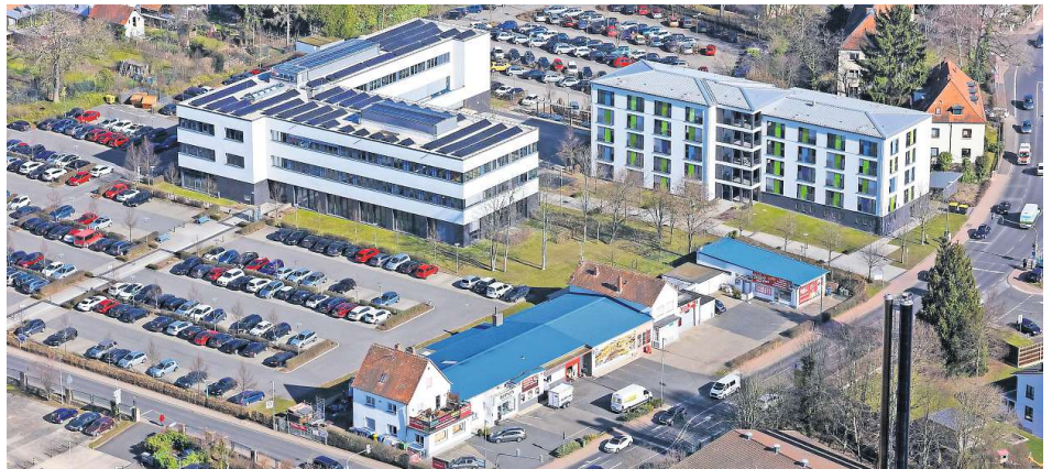
Das Gelände der Bildungspartner, auf dem das neue Ausbildungszentrum der Gesundheitsakademie entstehen soll.
